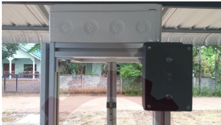
รูปที่ 7 ติดตั้งกล่องควบคุมเข้ากับโครงสร้างลิฟท์
