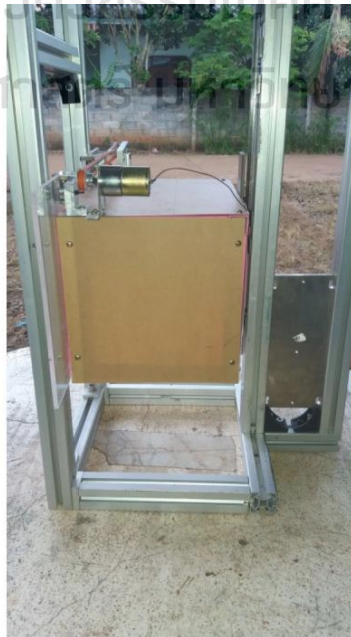
รูปที่ 6 ติดตั้งห้องผู้โดยสารเข้ากับโครงสร้างลิฟท์
